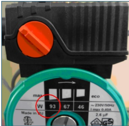
Abb. 1: An der abgebildeten Heizungsumwälzpumpe können drei Leistungsstufen eingestellt werden (roter Schalter). Eingestellt ist die Stufe 3, bei der die Leistungsaufnahme laut Typenschild 93 Watt (W) beträgt.
